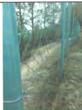
Foto 4: Sustrucción de malla de acero galvanizado en perimetro del establecimiento, con instalación fija y tensa, anclajes metálicos en intervalos irregulares.
