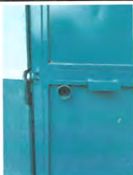
Foto 3: Suministro e instalación de puerta metálica, incluyendo chapa.
