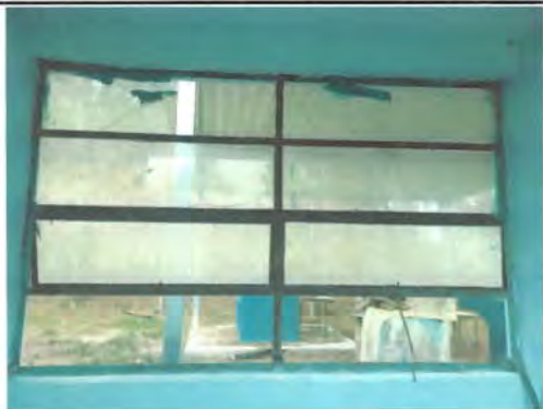
Foto1: Sustrucción de ventanas; sistema de apertura: Corredizas, Perfiles color blanco estandar, Material del marco: PVC Material de la ventana: Vidrio, sellado perimetral.
