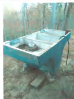
Foto 6: sustitución pila, nivelada y con conexiones hidráulicas.
