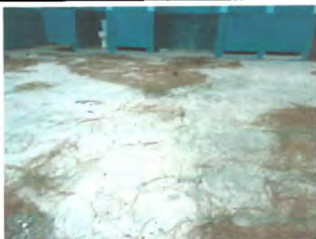
Foto 5: Reparación de losa de concreto para patios, considerando preparación de terreno, armado, nivelación y acabado rustico.
