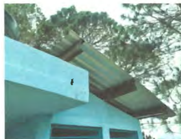
Foto 2: Mantenimiento a estructura metálica existente retiro de óxido, suciedad y pintura deteriorada; incluye cepillado, lijado y aplicación de pintura.
